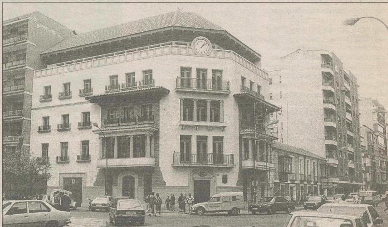
Edificio de la Caja Rural de Ciudad Real, entidad que dirigió Gregorio Martín durante diez años.
