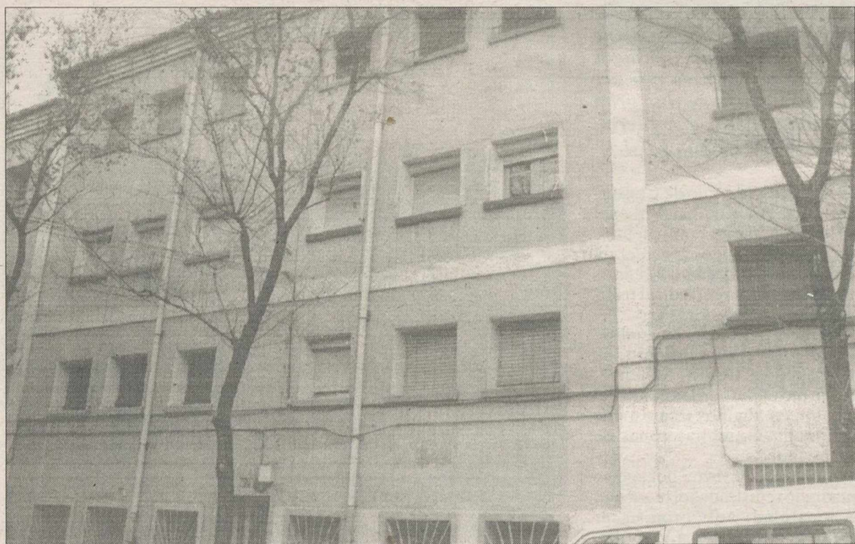
Los bloques de la calle Montesa han sido declarados en ruina.
