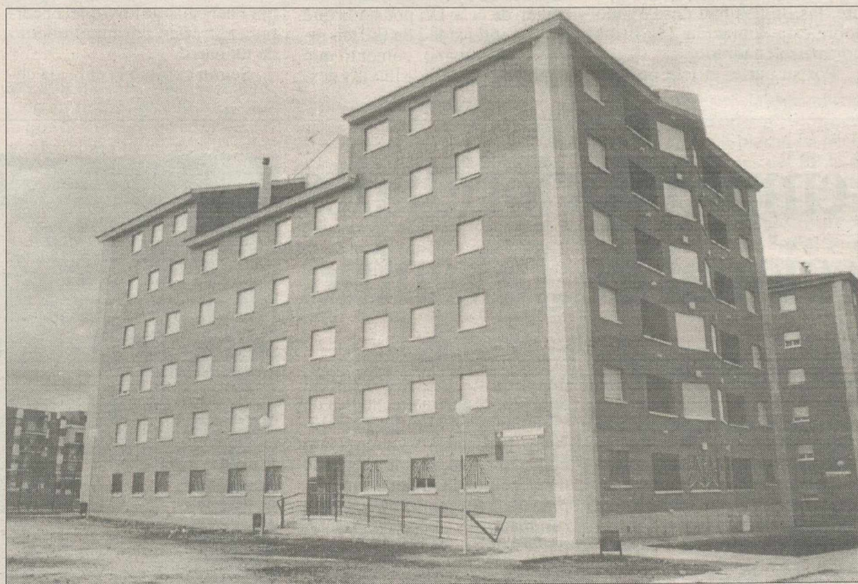
Las 33 viviendas de la calle Malagón serán entregadas en breve.
