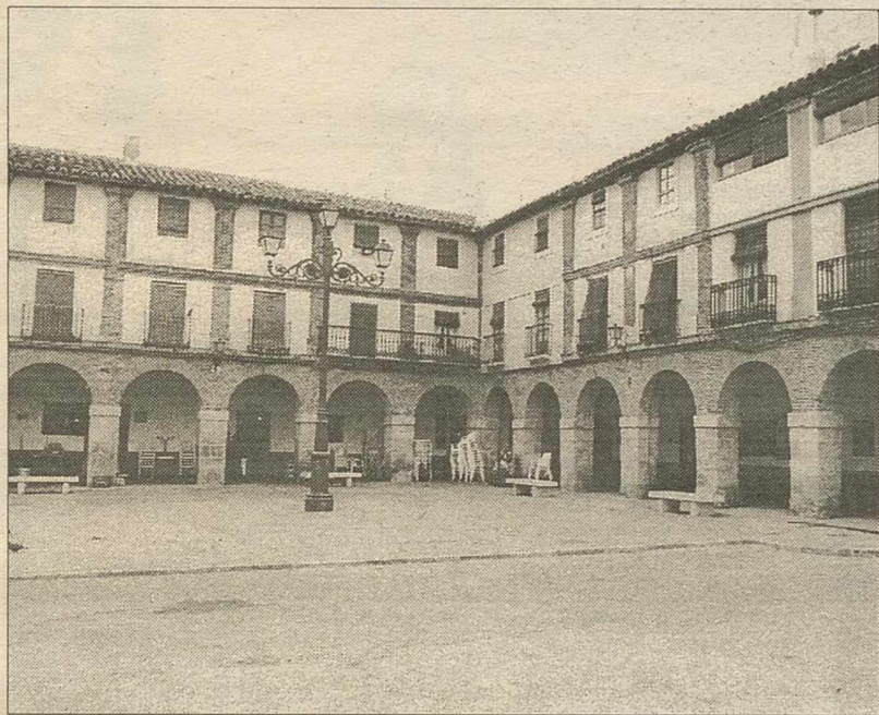
El Ayuntamiento recibió un edificio de 418 metros cuadrados. ARCHIVO
