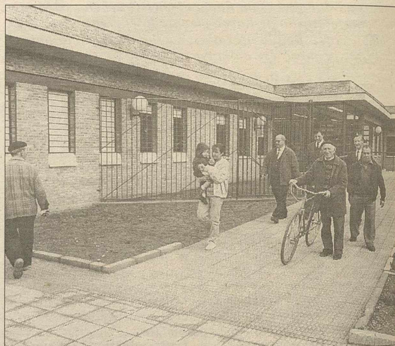
Vista exterior de la ampliación del Centro de Salud de Malagón. RUEDA
