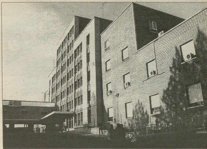
La herida ingresó en la Planta de Traumatología de Alarcos.
