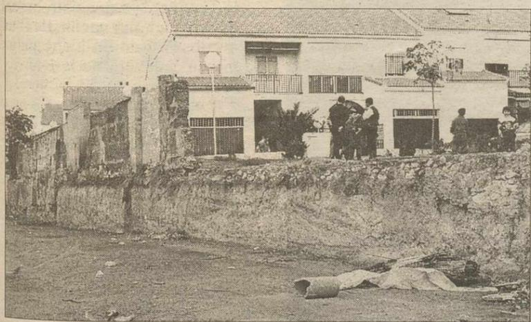
El muro se cae por las vibraciones de la maquinaria.
