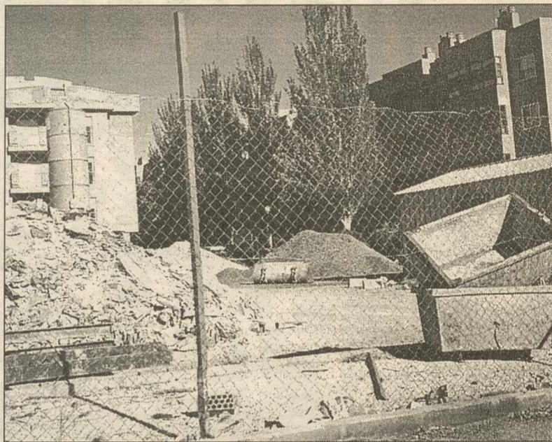
Terrenos donde se construirán las 98 viviendas.
