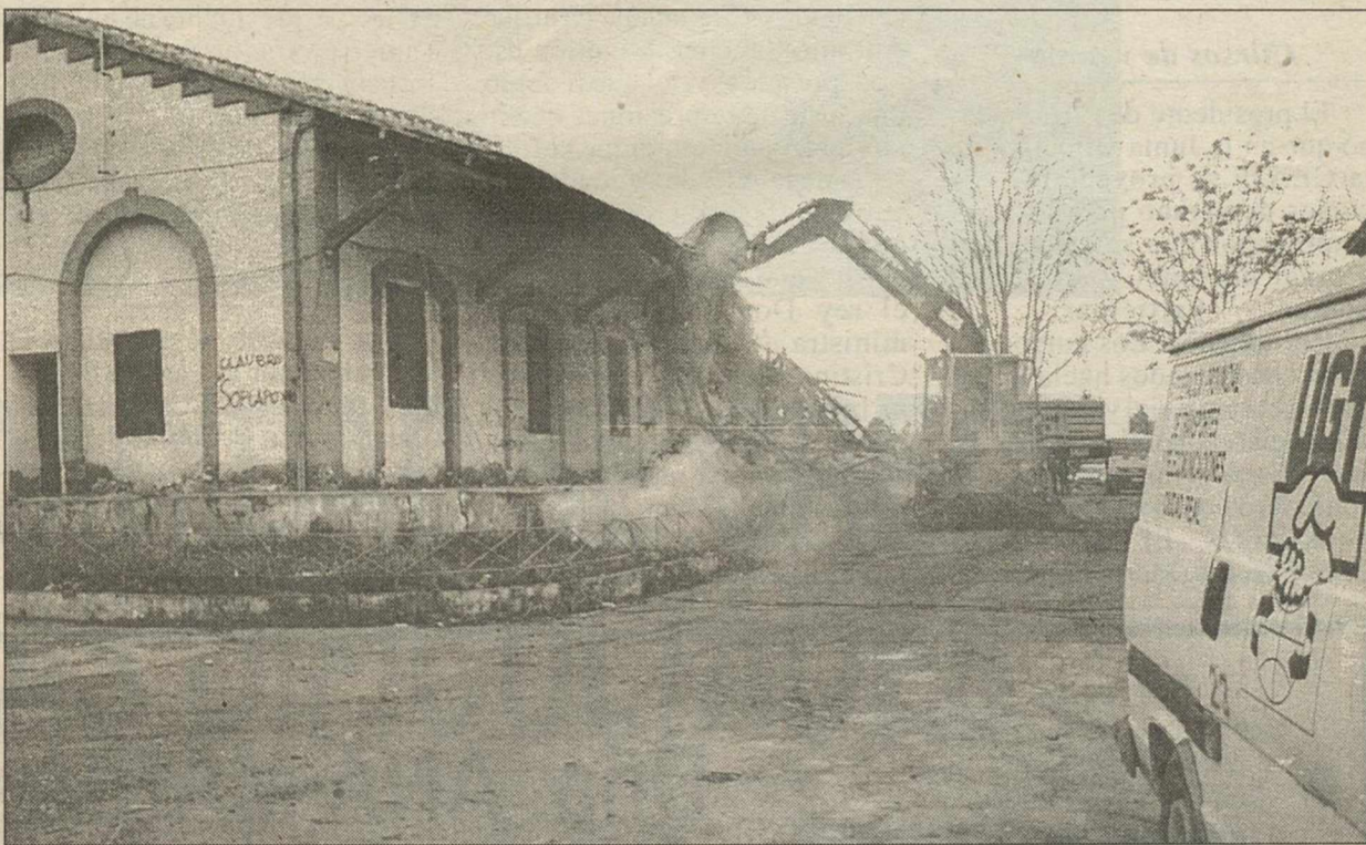
Tras ser desalojado el antiguo muelle de carga (sede de UGT-Transportes), fue demolido por la tarde.
