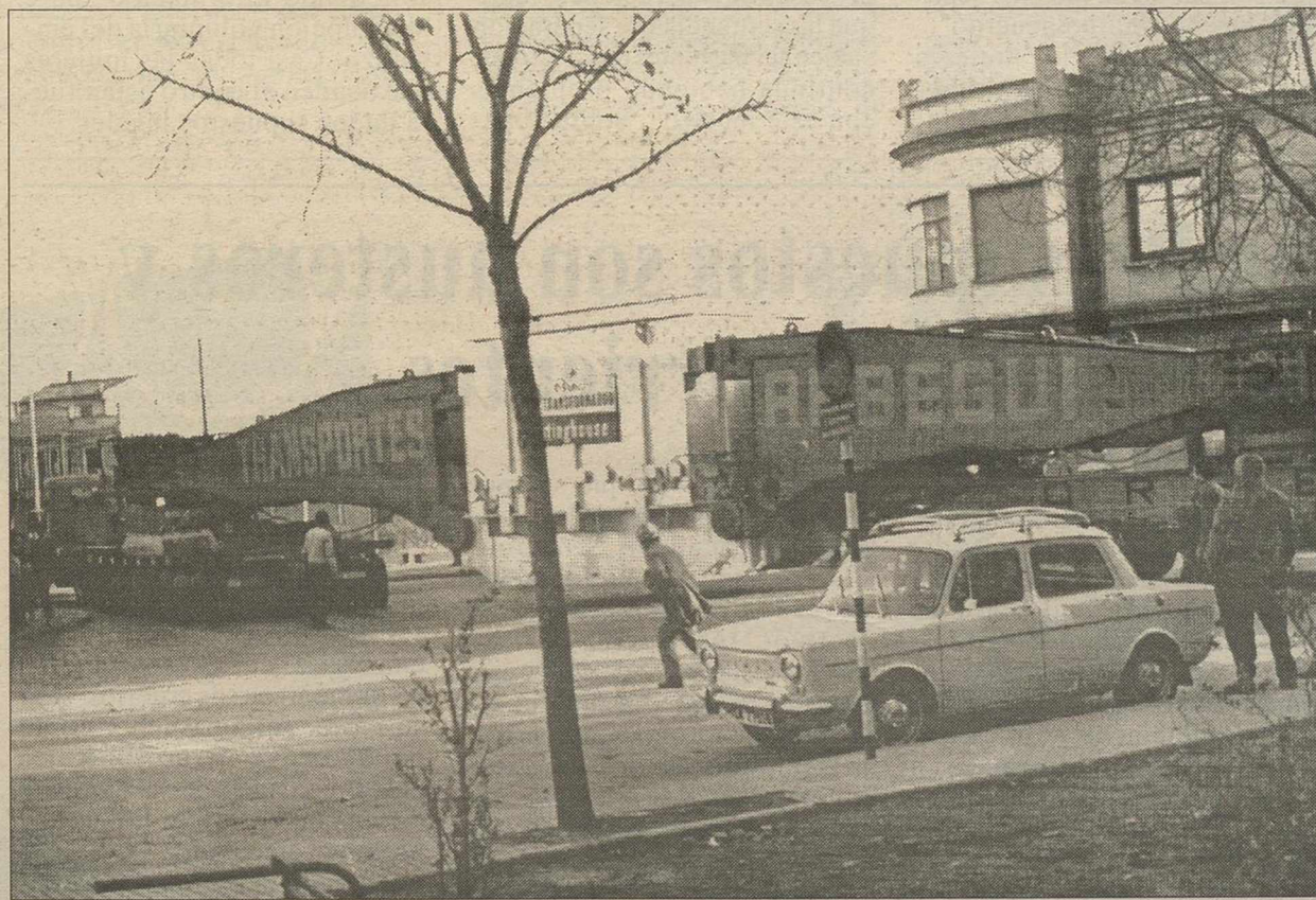
Este transporte para ampliar el Complejo se ha hecho ya en Puertollano, como prueba esta foto de 1970.
