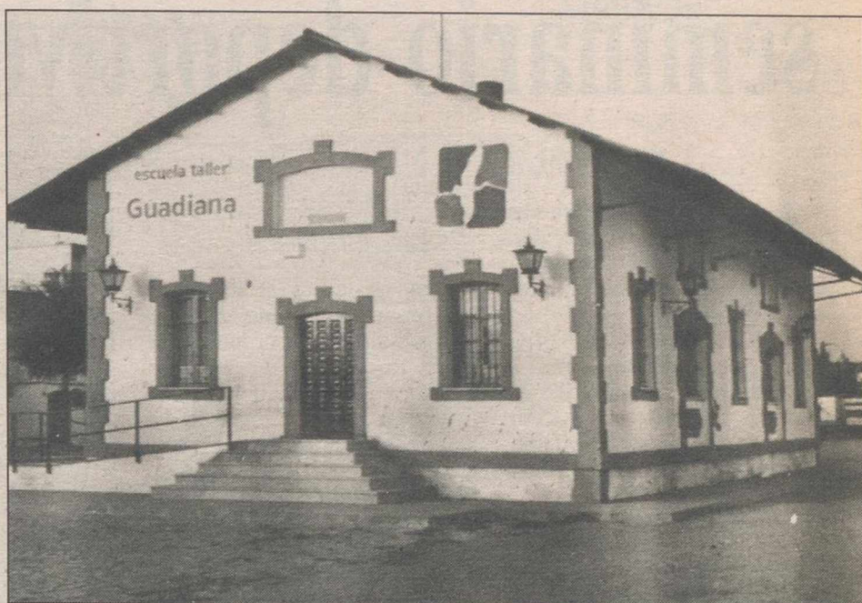
RUEDA. Edificio que ha sido restaurado por los socialistas de Ayamonte.
