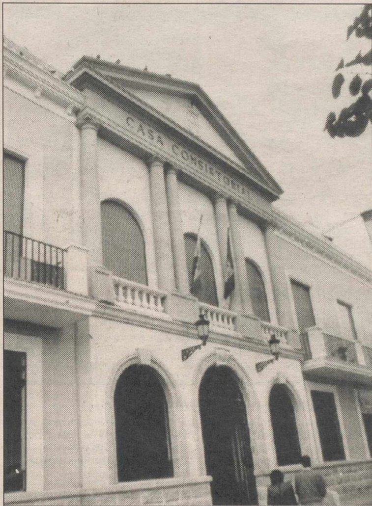
Los servicios de la oficina quedarán ubicados en una planta baja del Ayuntamiento.
