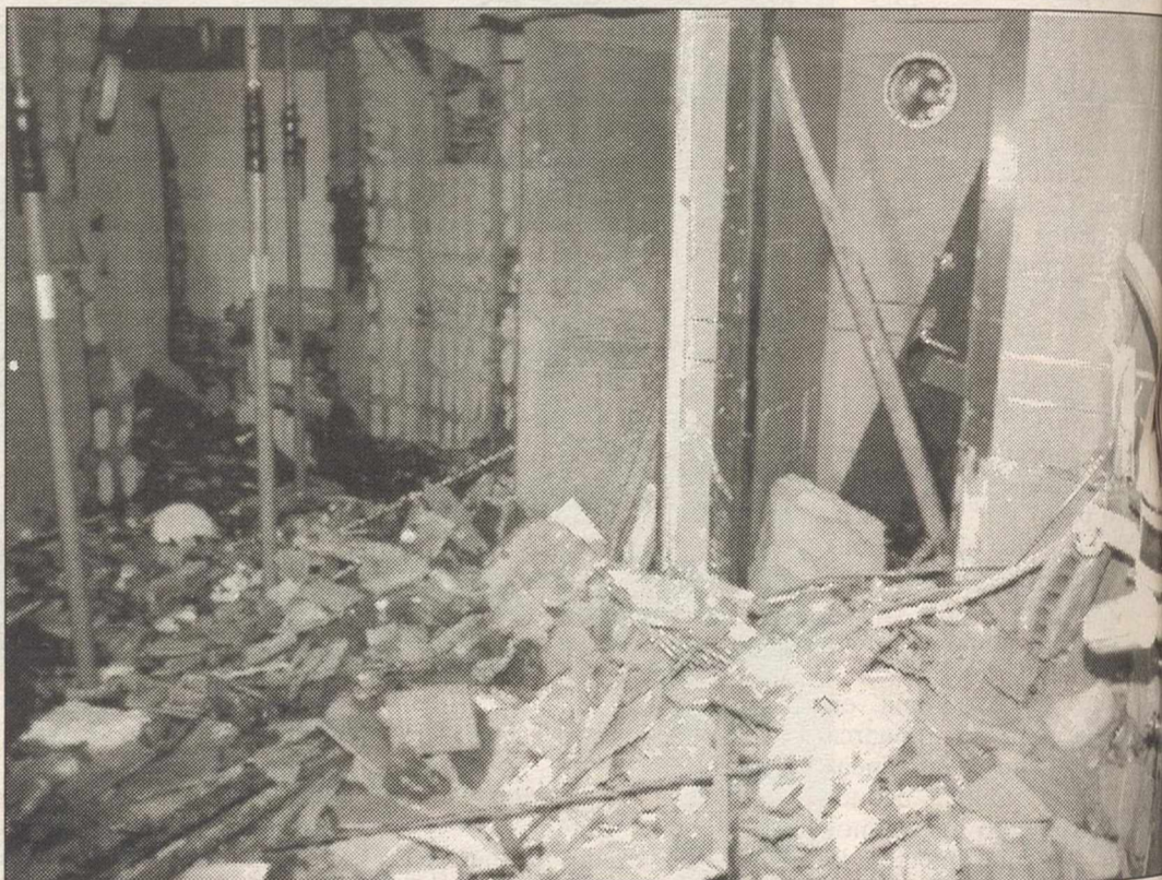
La bomba desactivada estaba colocada en un falso techo de los lavabos de la cafetería.
