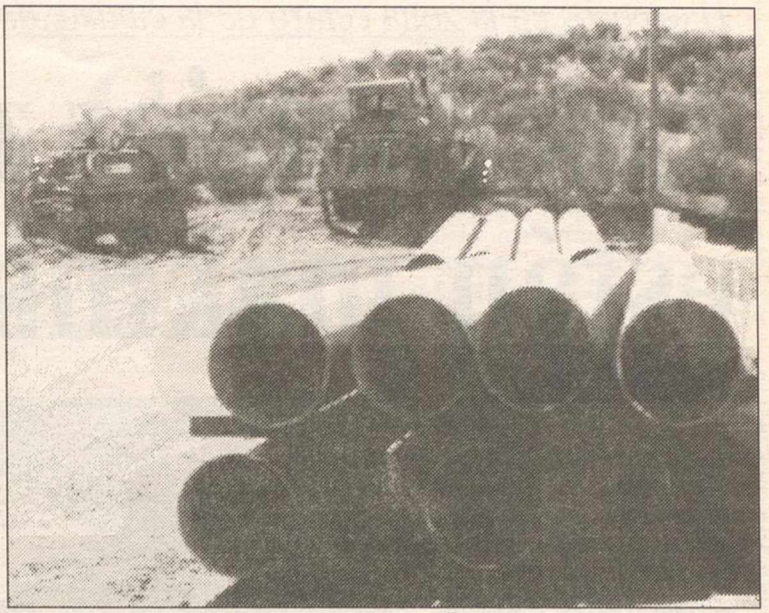
Obras del trasvase en Mestanza.
