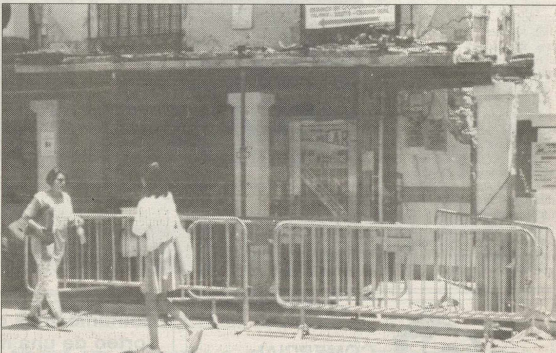
La armería contigua será derribada durante la próxima semana
