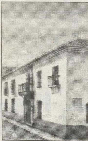
Una de las obras de Corral.
