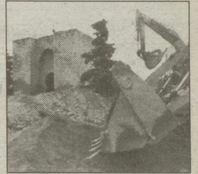
La Puerta de Toledo, en obras.
