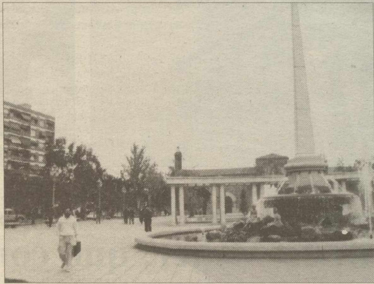
Las obras incluyen el ajardinamiento de zonas libres.
