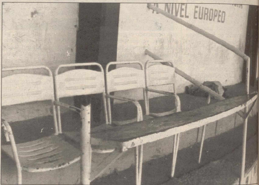
Pese al rótulo el nivel de instalaciones es tercermundista
