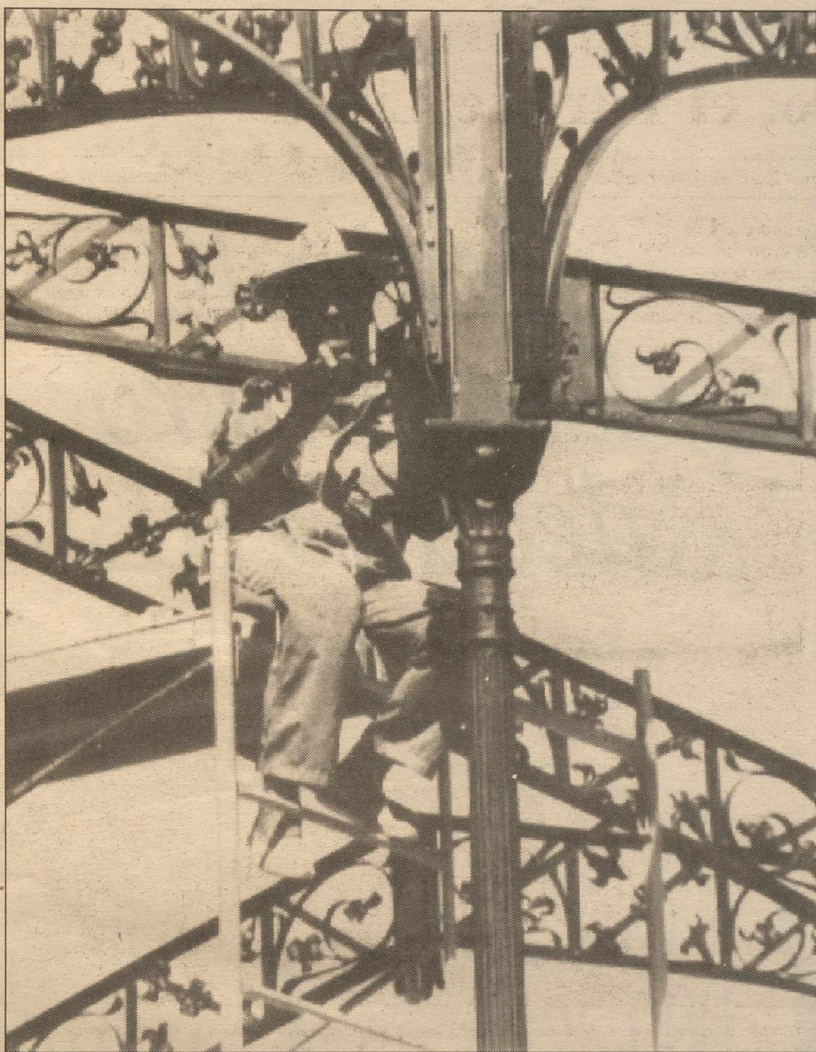
Su conclusión estaba prevista para la Feria, pero aún está sin terminar el templete en el Parque Lineal.
