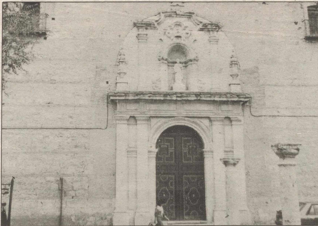
La remodelación del interior de la iglesia ya ha concluido.
