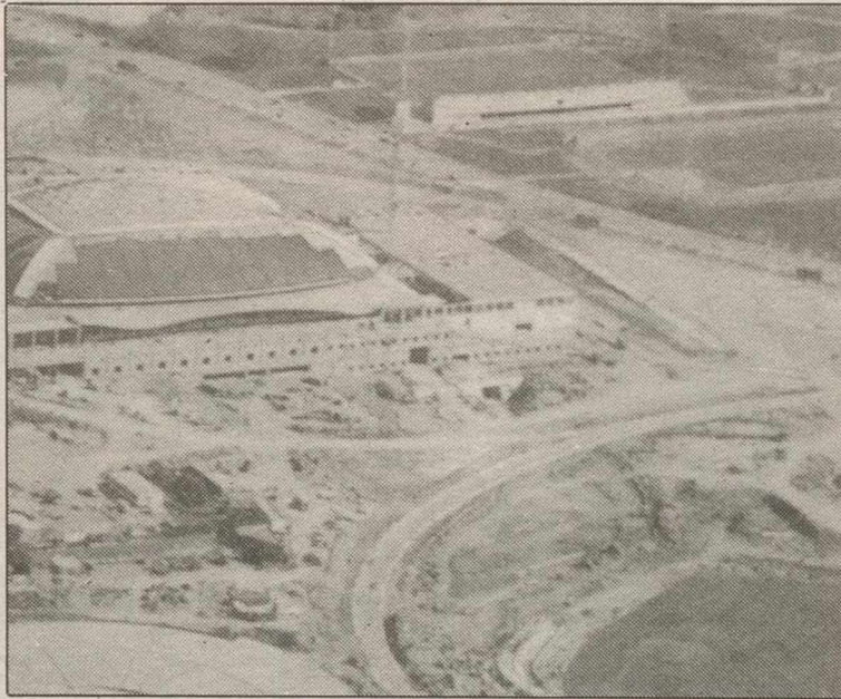
Las obras de infraestructura harán que la Barcelona del 93 sea mejor.
