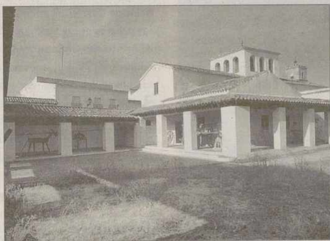
La primera fase de las obras concluirá en abril. / DAVID PÉREZ
