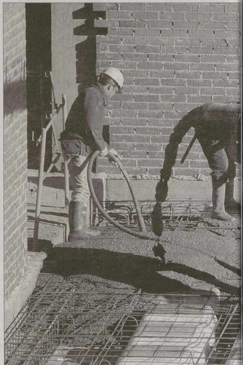
Un buen número de inmigrantes trabaja en el sector de la Construcción. / DAVID PÉREZ
