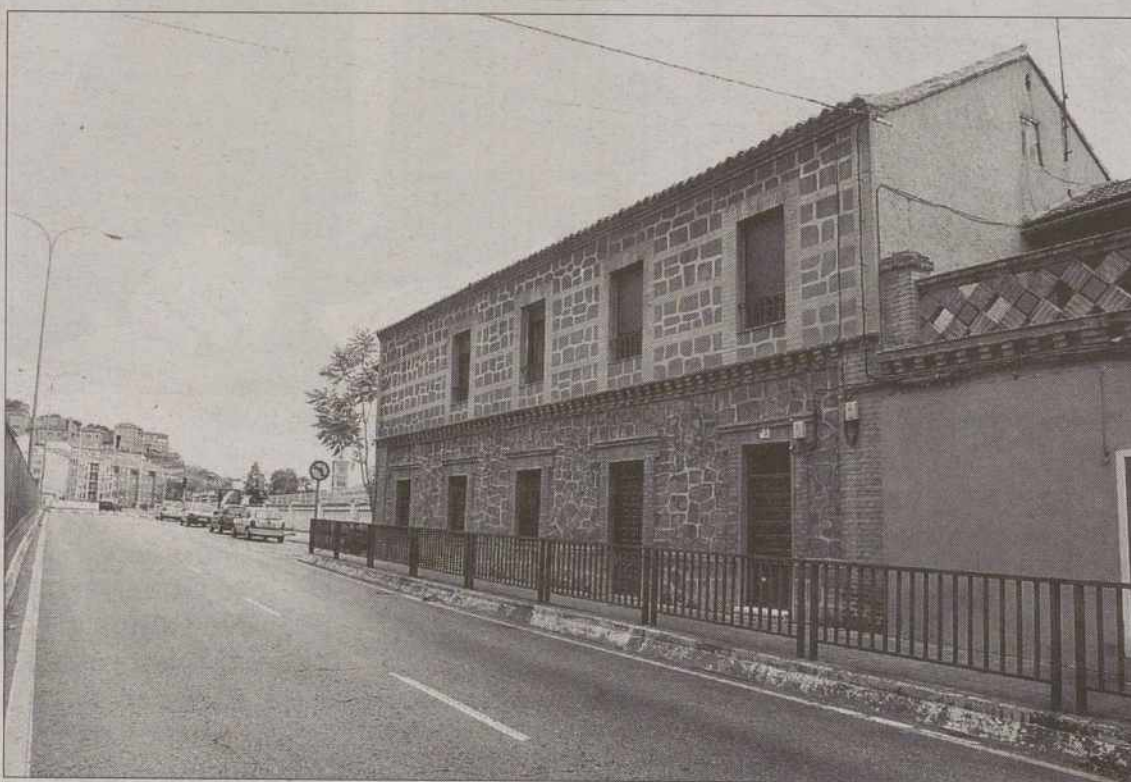
Las viviendas a expropiar a la derecha, para continuar con las obras. / YOLANDA REDONDO
