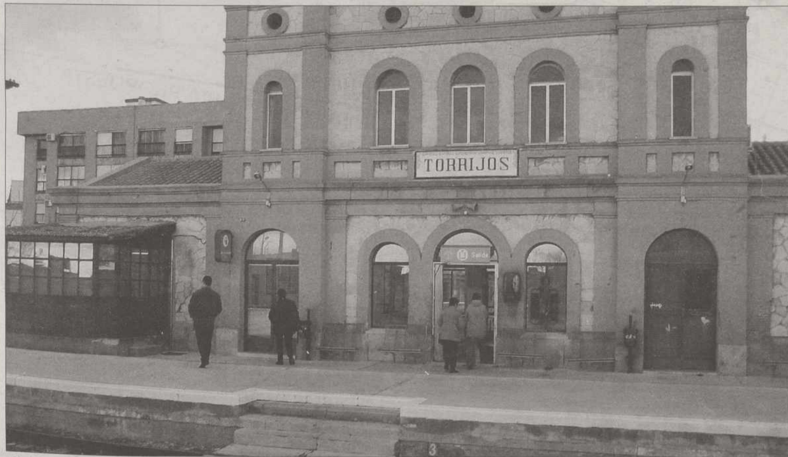
Estación de trenes de Torrijos./C.S.
