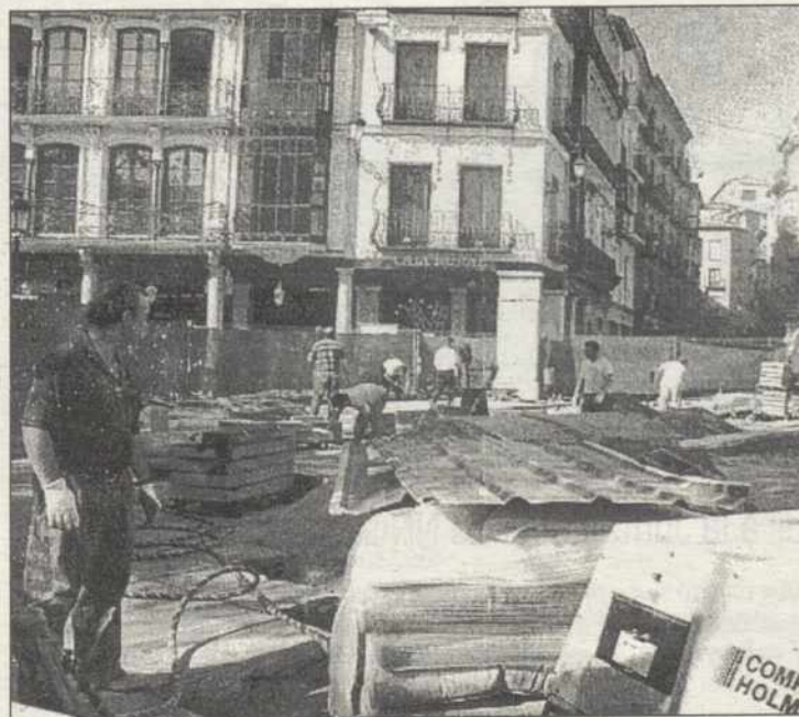
Avanzan las obras de renovación del pavimento
