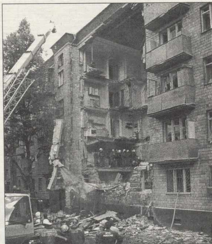
Estado en el que quedó el edificio siniestrado
