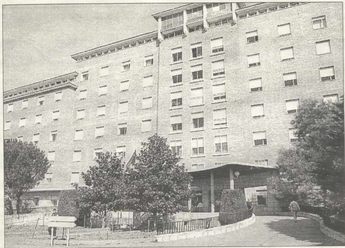
La acceso principal al Centro Hospitalario de Toledo
