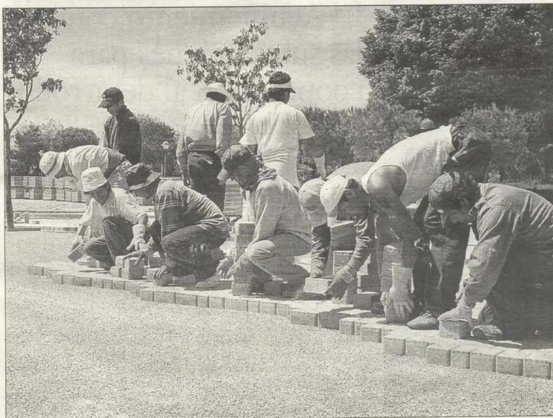
Un grupo de trabajadores se afanan ayer en la colocación de los adoquines
