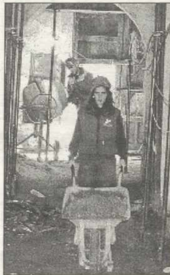
Transportando escombros VADERO
