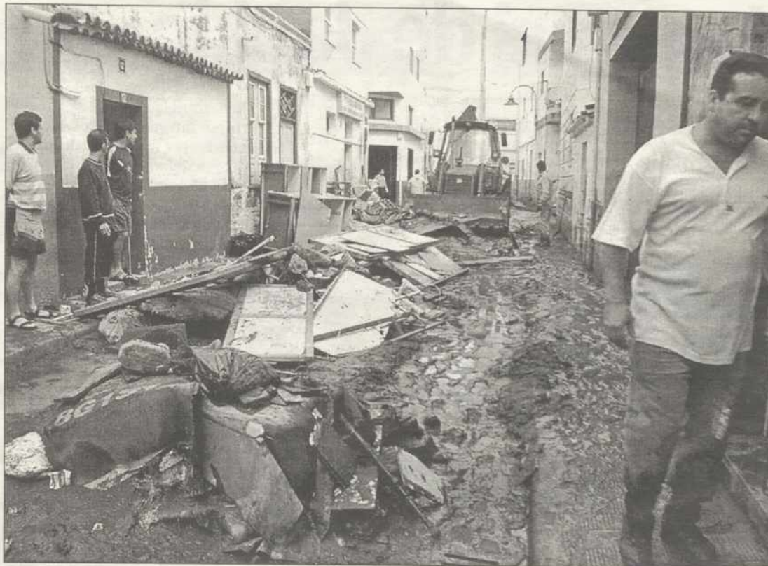
Varios vecinos del barrio de San Andrés retiran lodo y escombros de sus casas
