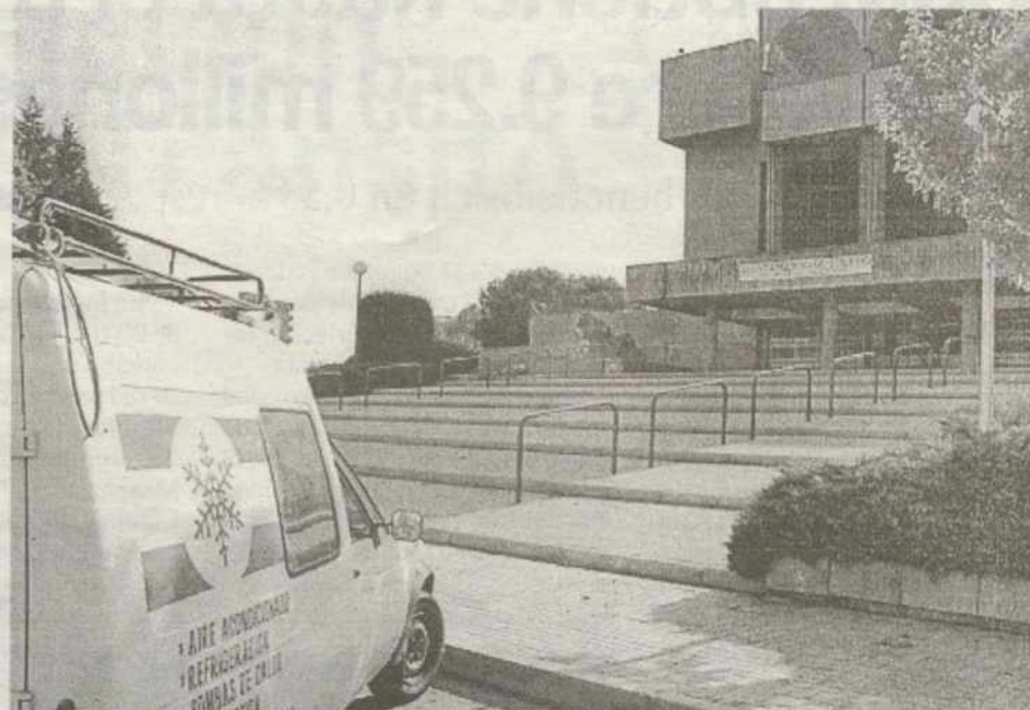
Biblioteca a falta del aire acondicionado
