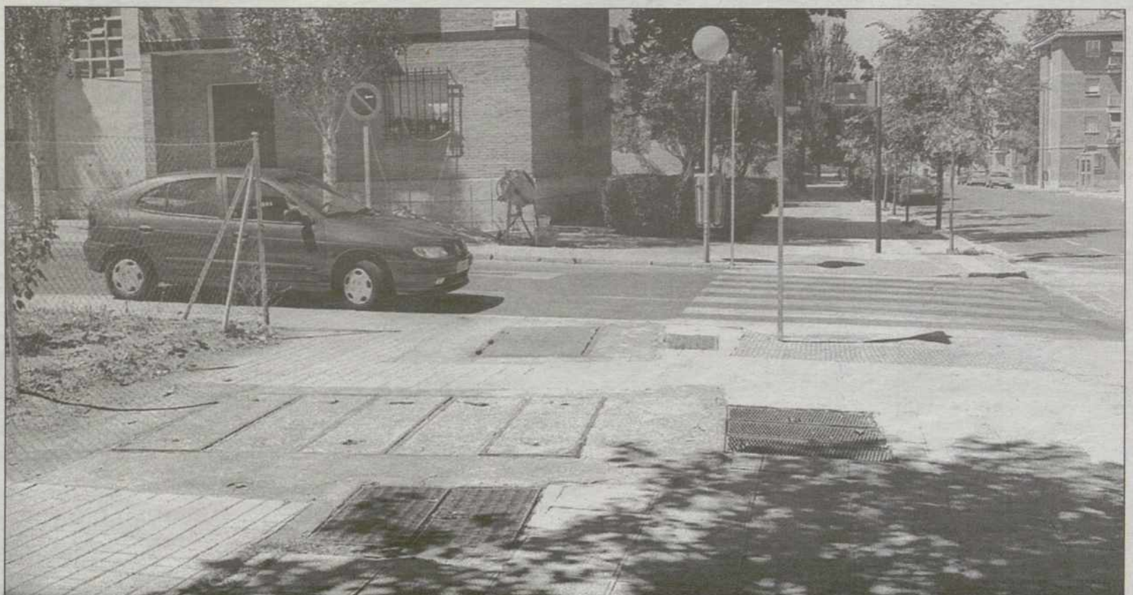
El barrio del Polígono necesita "varios retoques" en muchas de sus calles, esta operación mejorará los desperfectos ocasionados por el paso del tiempo Yolanda Lancha
