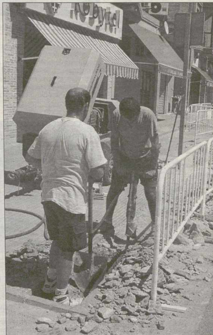
Las obras de instalación comenzaron a ejecutarse en 1998
