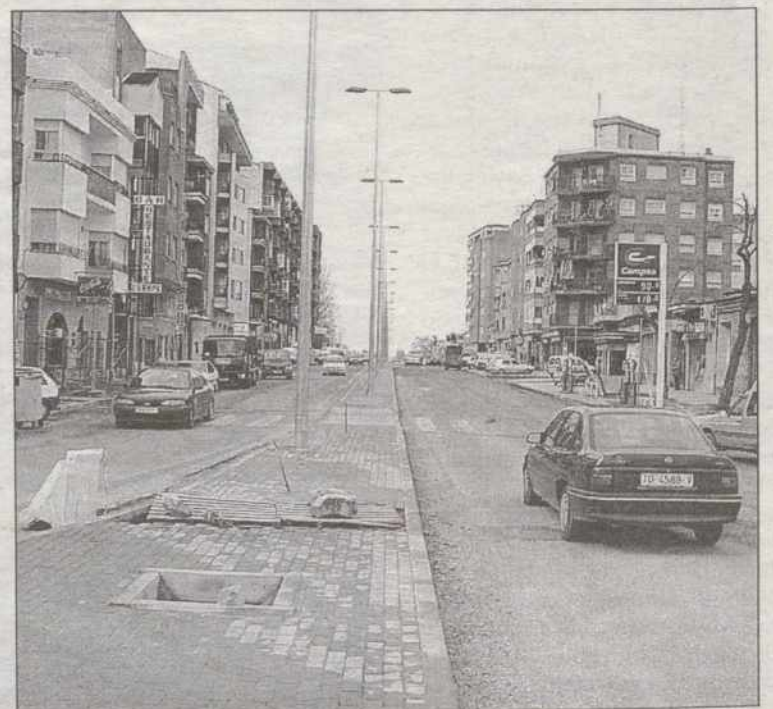
La avenida de Portugal lleva más de un año en obras
