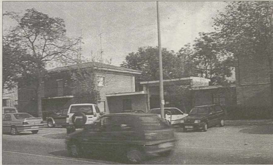
El futuro Palacio de Justicia se levantará en los terrenos de la antigua cárcel
