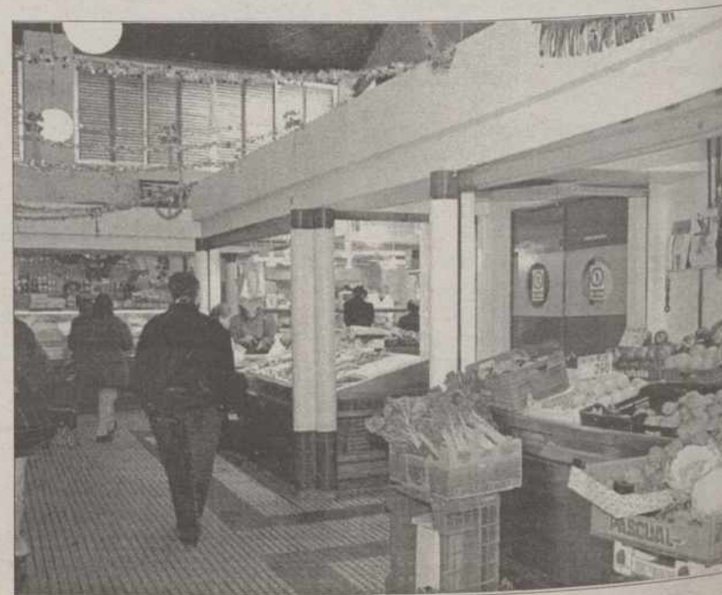
El antiguo Mercado de Minoristas quedará dividido en dos.
