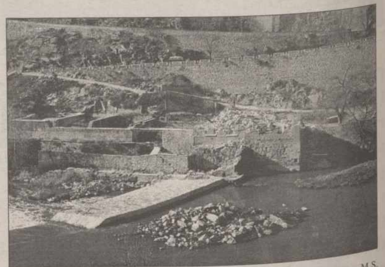
El edificio Vargas fue demolido el pasado viernes, 15 de enero.
