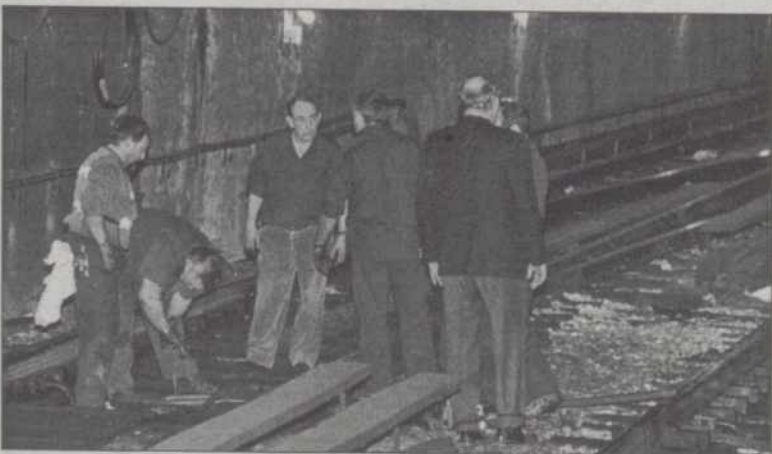
Trabajadores del metro de Barcelona reparan las vías de la estación.
