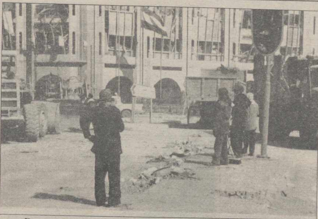
DAÑOS EN LA CIUDAD. — BAGDAD (IRAK).— Esta fotografía tomada por el corresponsal de AP Dilip Ganuly en Bagdad muestra un edificio cerca de la calle Haifa en el centro de la ciudad, dañado por las bombas aliadas. Se desconoce con exactitud la fecha en la que fue hecha la fotografía, aunque sí que corresponde a la semana pasada. (EFE AP)
