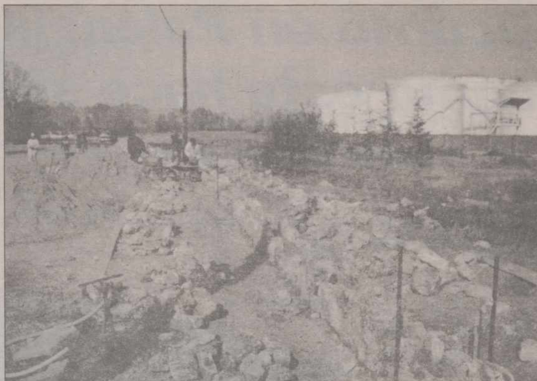
Se iniciaron las obras del Parque Municipal de Venta de Baños, que está construyendo la Escuela Taller.-(Foto OLEA)
