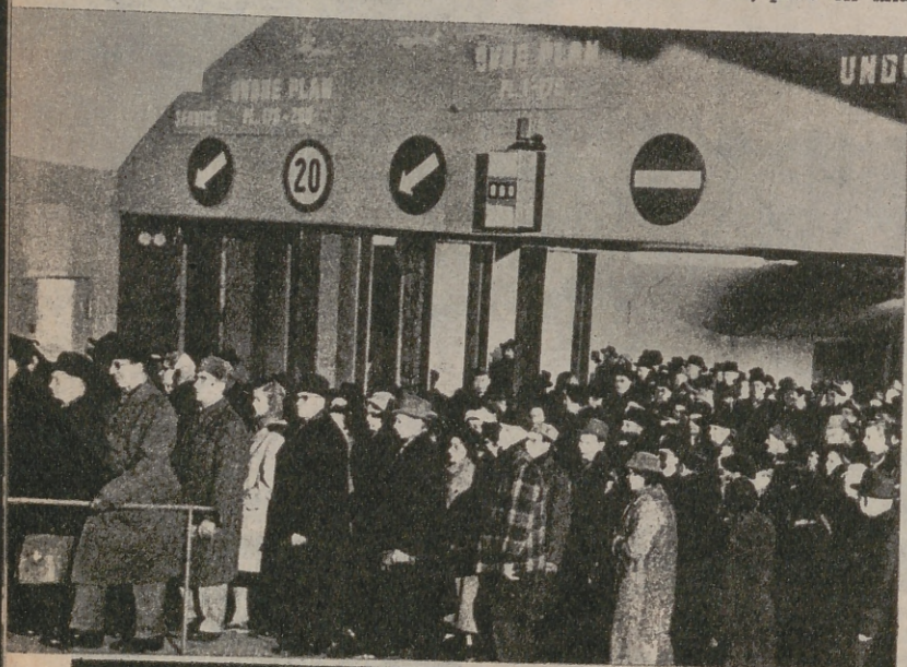
La fotografía muestra la entrada de un refugio atómico. Tras la alarma, las puertas de acero se abren para resguardar a los habitantes
