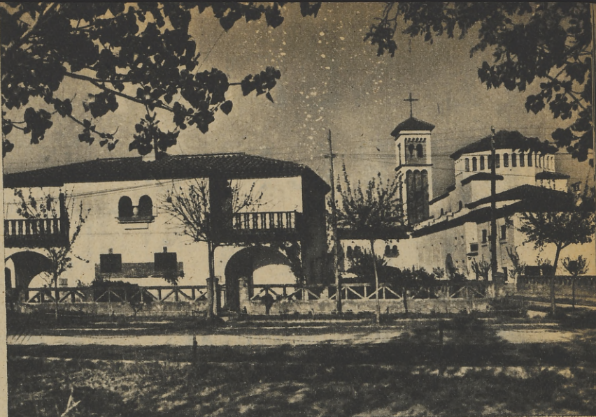
Vista parcial del grupo de viviendas «San Narciso»
