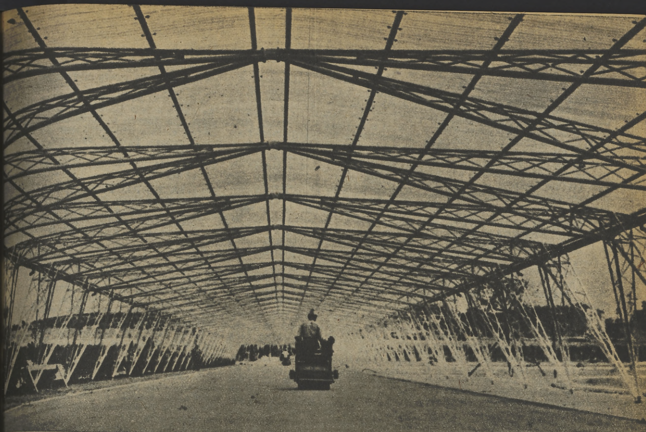
La pista cubierta para entrenamiento de carreras de velocidad. Chapas plásticas y soportes de aluminio forman la estructura.
