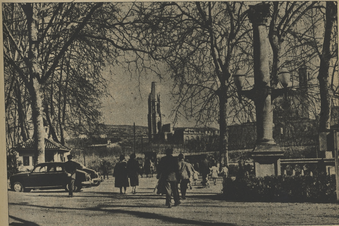
Entrada al paseo principal del parque de la Dehesa
