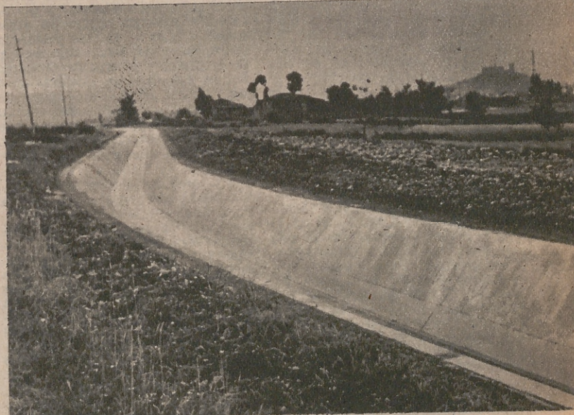
Vista del tramo del canal de riego «Valle de Lemos», que dotará de agua a una vega de más de 3.000 hectáreas
