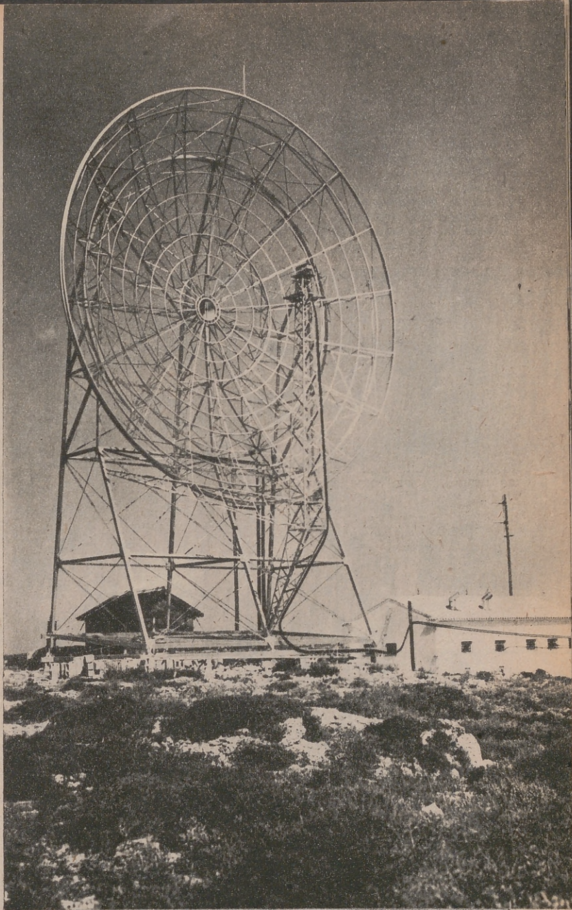
Antena parabólica en Mahón, para el enlace telefónico. Otra muestra de la alta técnica de la soldadura
