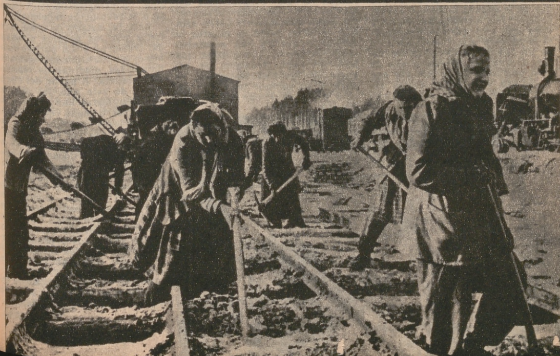
En la construcción de una línea férrea en Alemania oriental las mujeres trabajan en condiciones infrahumanas
