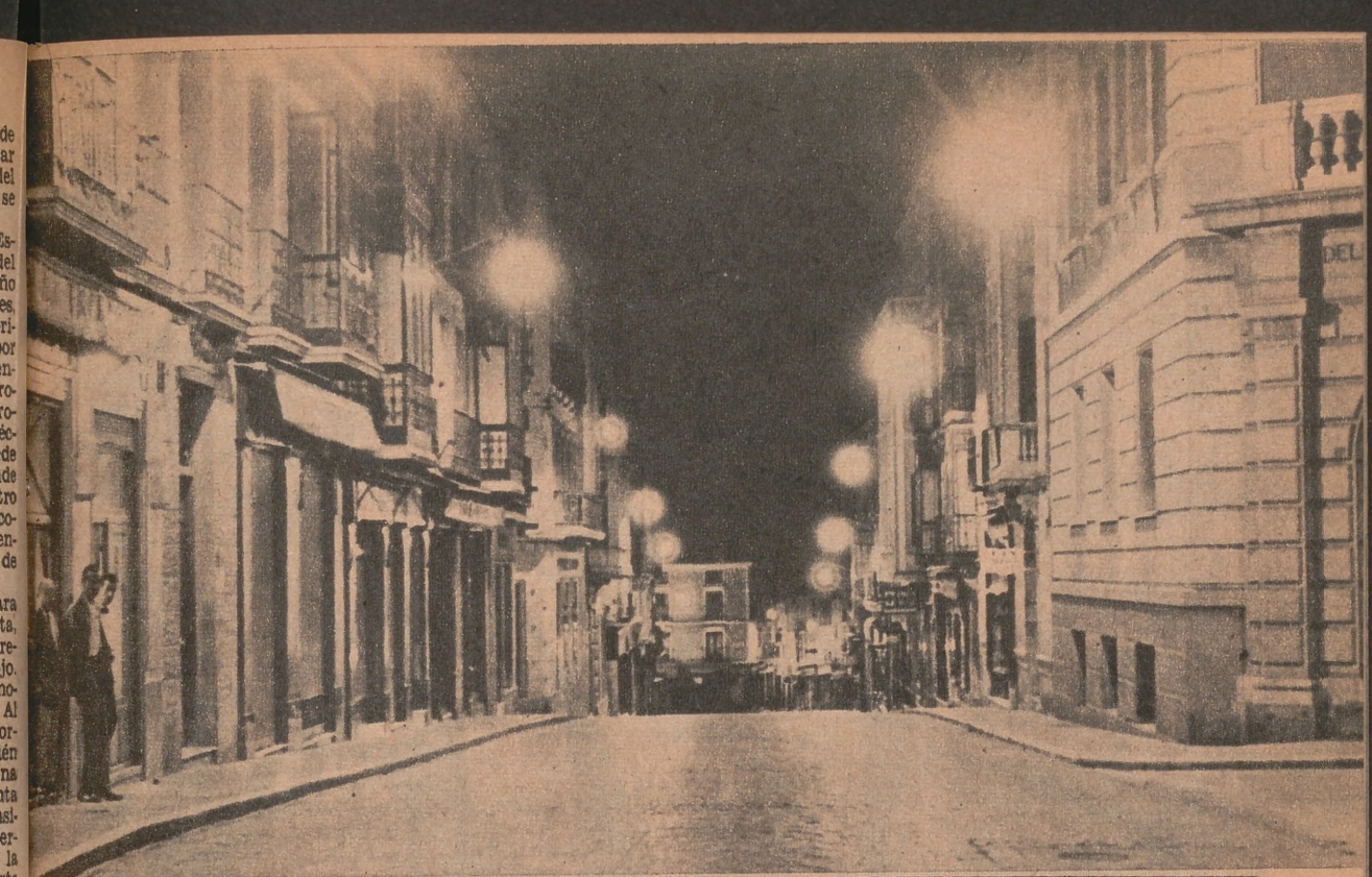
Otro ejemplo de moderna iluminación: Esta calle de Guadalupe
