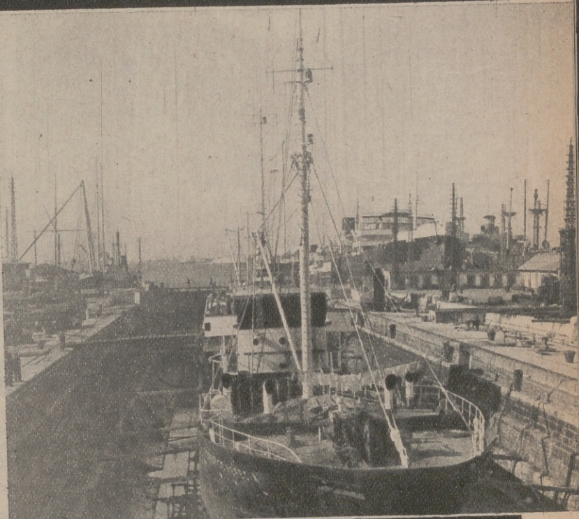
Uno de los diques secos de la factoría de Matagorda en Puerto Real. Al fondo, la costa de Cádiz.
