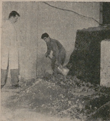
De esos montones de tierra de aspecto arcilloso saldrá uranio puro capaz de alimentar una pila atómica. El molino de bolas, a la derecha, recibe la carga de tierras ricas en uranio
