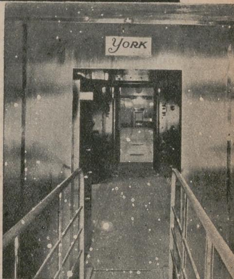
El puente deslizante que al correrse abre un foso de 35 metros de profundidad que puede ser totalmente inundado de agua
