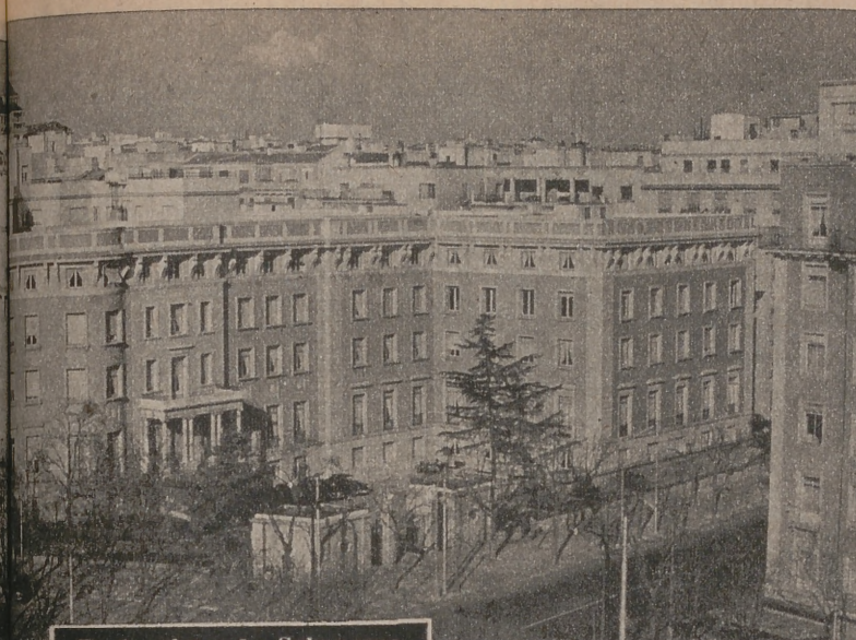
En la plaza de Salamanca se levanta este edificio para sede del Instituto Nacional de Industria
