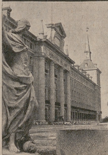
Fachada principal del nuevo Ministerio del Aire
