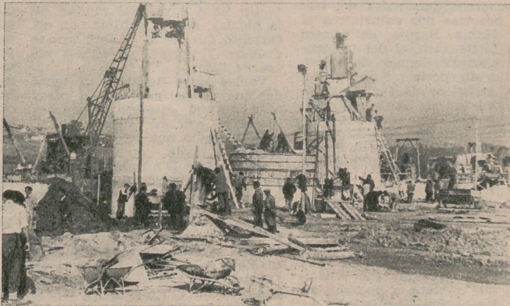
En estos tubos de hormigón tendrán cabida las calderas gigantes que intervienen en la fabricación del acero.
