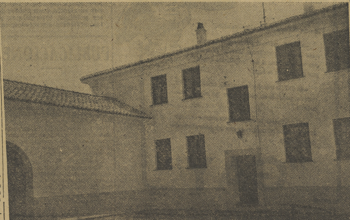
Vista interior del cuartel de la Guardia Civil, inaugurado en Corbera de Alfranca
