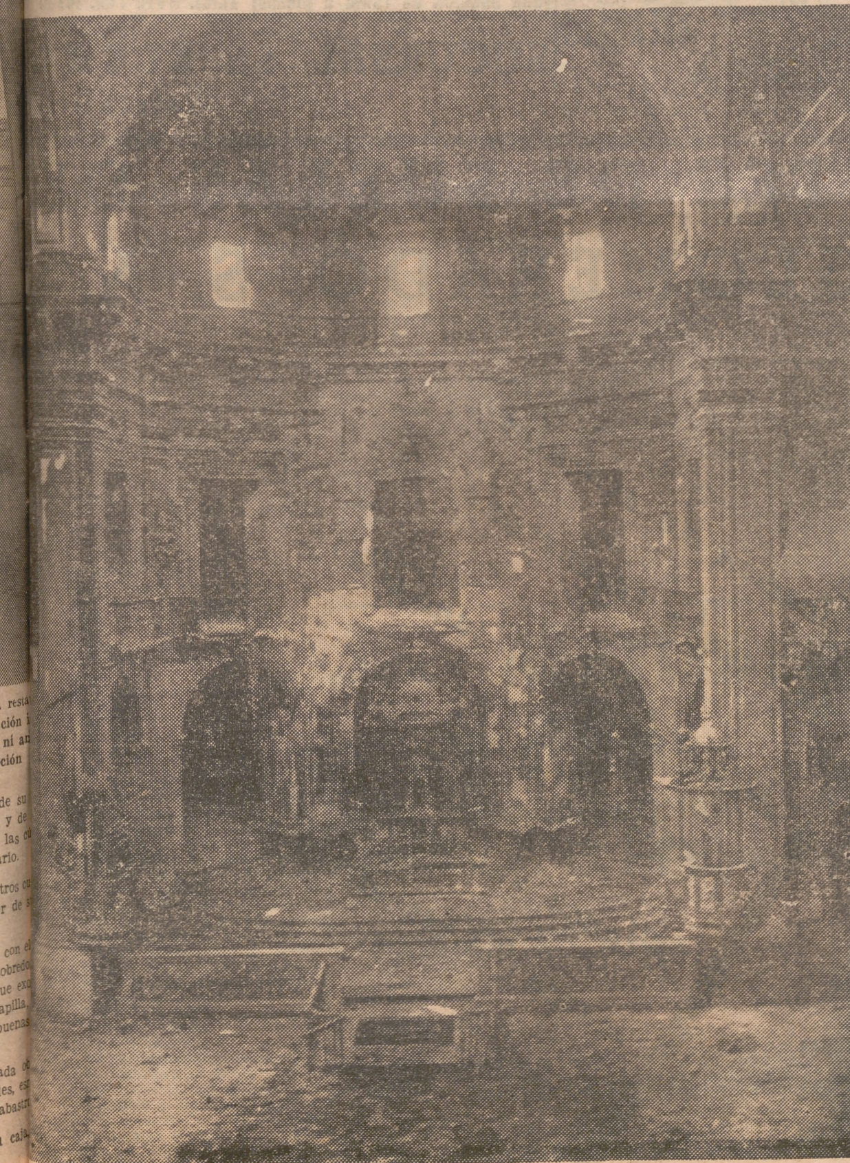
ASPECTO DE LA IGLESIA DE SANTA MARIA, DESPUES DEL INCENDIO
