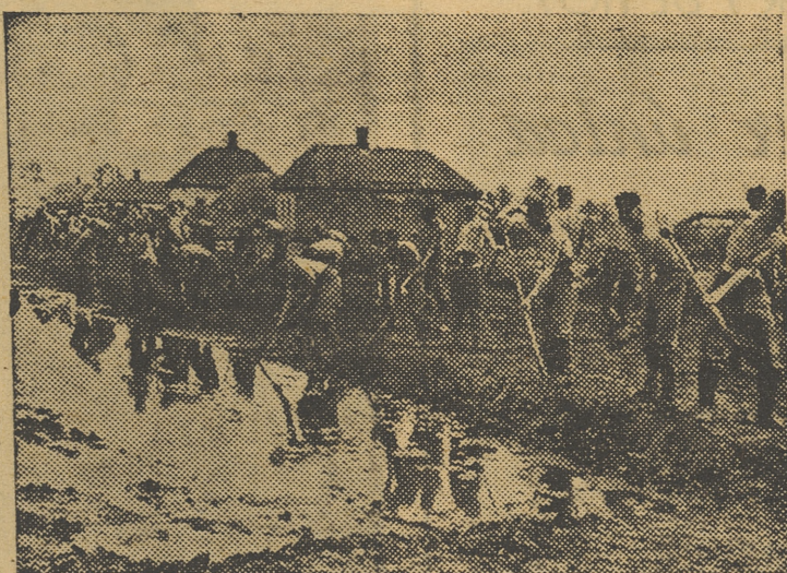
Una sección del Servicio de Trabajo alemán repara una carretera, que por su mala construcción casi desapareció durante el avance de las unidades blindadas alemanas (Foto Presamundo).
