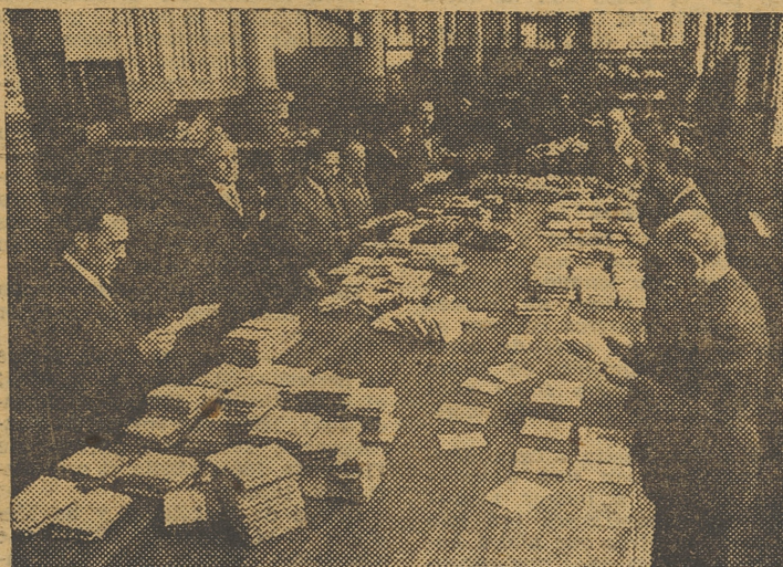
La sala de distribución
